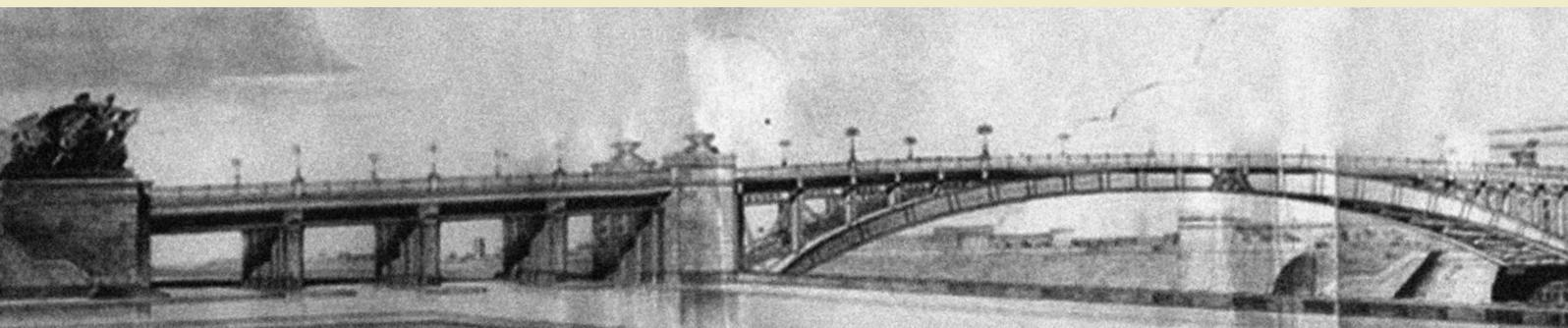
Смоленский мостометр двухпутный, с шириной междупутья 3,55 м. Трасса его в целом прямолинейная, а на правом берегу при выходе с моста начинается кривая малого радиуса – трасса уходит на юг, к Киевскому вокзалу. В основе моста – две пологие главные арки, длиной 150 м со стрелой подъема 11,04 м (7,4 %). Максимальная высота П-образного профиля арки 2,7 м (1,2 м у шарниров). Расстояние между арками – 9,5 м.
