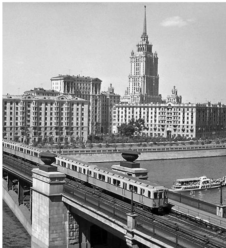
Материал – Сталь 5 (для второстепенных деталей – Сталь 3). Помимо главного пролета, мост имеет пять береговых железобетонных арок, полная схема пролетов такова: 19,225 + 20,5 + 19,225 + 150,0 + 19,225 + 19,225 м.
