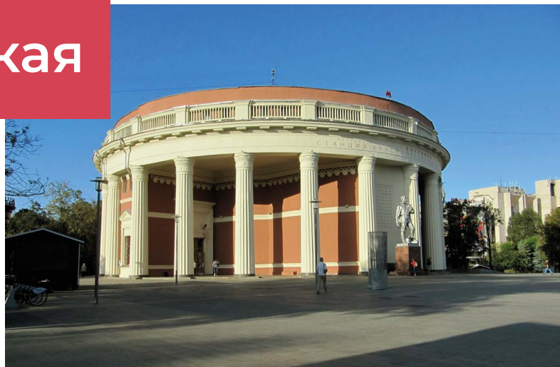
Наземный вестибюль станции «Краснопресненская»
