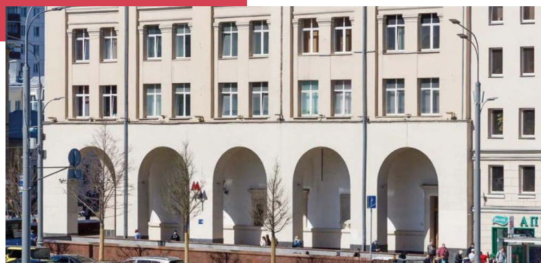
Наземный вестибюль станции «Павелецкая»
