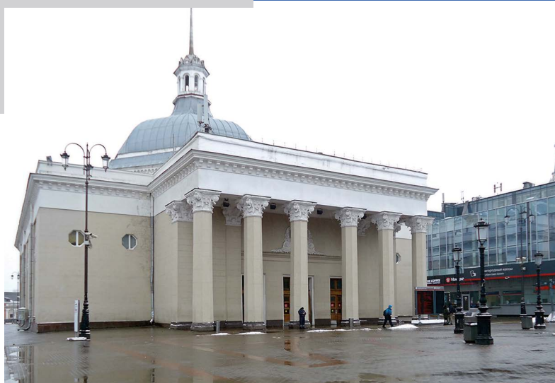
Наземный вестибюль станции «Комсомольская»
