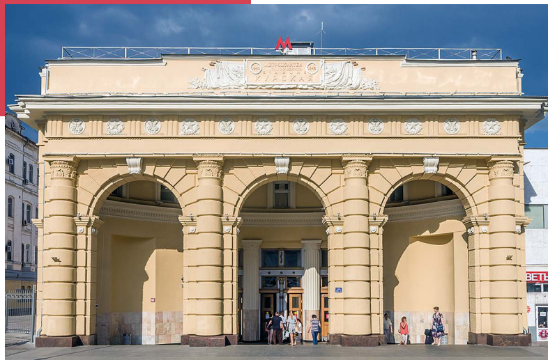
Наземный вестибюль станции «Курская»
