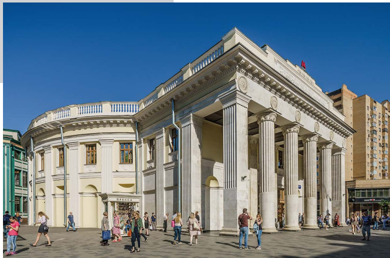
Наземный вестибюль станции «Новослободская»
